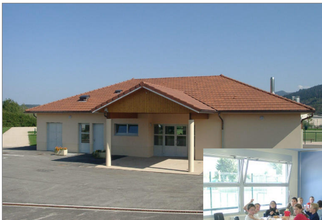
Les locaux neufs de GROISSIAT
